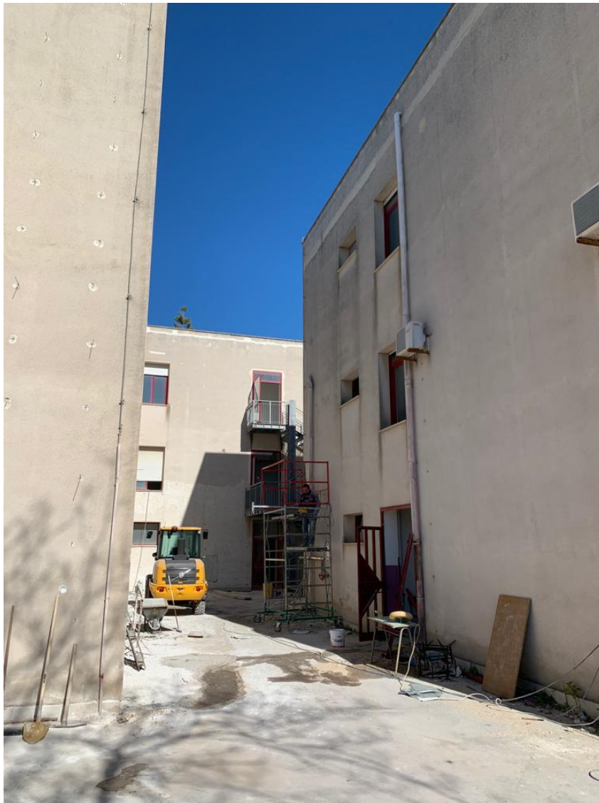
Fig. 4: Stato di fatto cantiere
