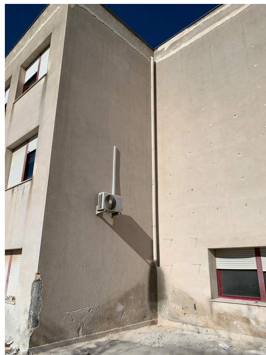
Fig. 3: Elementi impiantistici/discendenti pluviali
